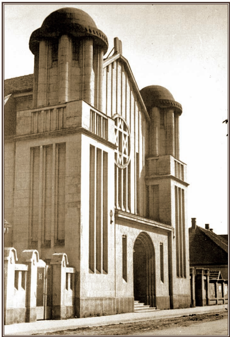
Glavno pročelje sinagoge u Bjelovaru, snimljeno prije adaptacije 1951. godine
