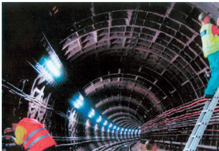
Slika 9. Sustav za mikro-mjerenje i monitoriranje starenja podzemnih infrastrukturnih objekata
