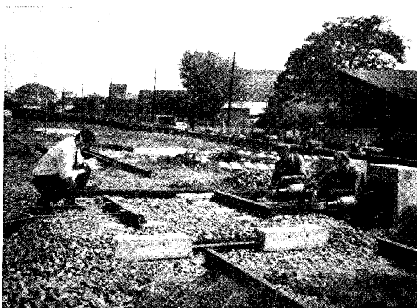
Slika 5. Izgled pragova Z. 1 i Z. 2 i ispitivanje bočnog otpora kolosijeka s tim pragovima
