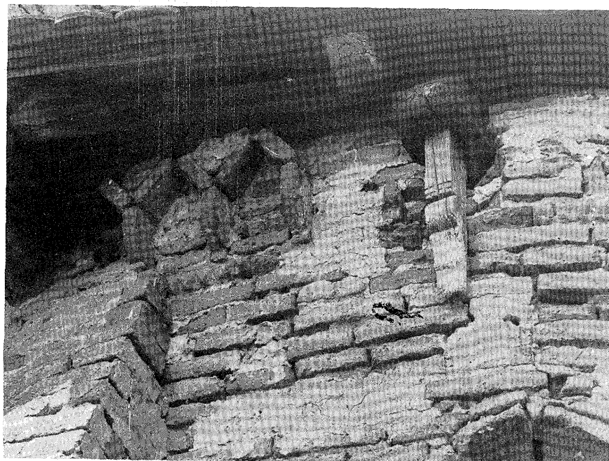
Majka Božja na Groblju u Bapskoj — detalj potkrovnog vijenca
