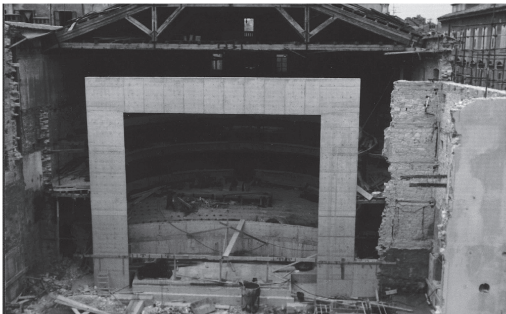
Pogled na zgradu Istarskoga narodnog kazališta tijekom obnove s uklonjenim stražnjim dijelom, uključujući pozornicu, a prije dogradnje novoga, većeg stražnjeg dijela. Obnovom i dogradnjom znatno je proširen i produbljen pozoriški prostor, gledalište, koje je na slici još netaknuto, obnovljeno je i preuređeno, u dograđenom stražnjem dijelu uređene su nove prostorije za tehničke službe i glumce, a u obnovljenom prednjem dijelu uredi, mala dvorana i izložbeni prostori.
