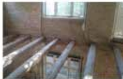
Pojatina, Potresno inženjerstvo - Obnova zidanih zgrada, 2021
