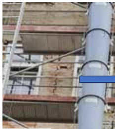
ITV2, sanacija teško oštećenog zida
