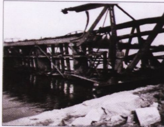
59. Most na Dravi kraj Varaždina GMV 43 109 nepoznat autor, Varaždin, 1941. fotografija, 13x8 cm Detalj porušenog mosta na Dravi kraj Varaždina
