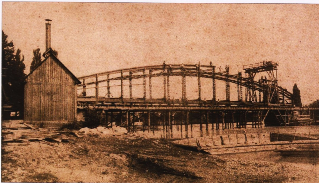
Podizanje željezničkog mosta na Dravi, Varaždin 1885.
