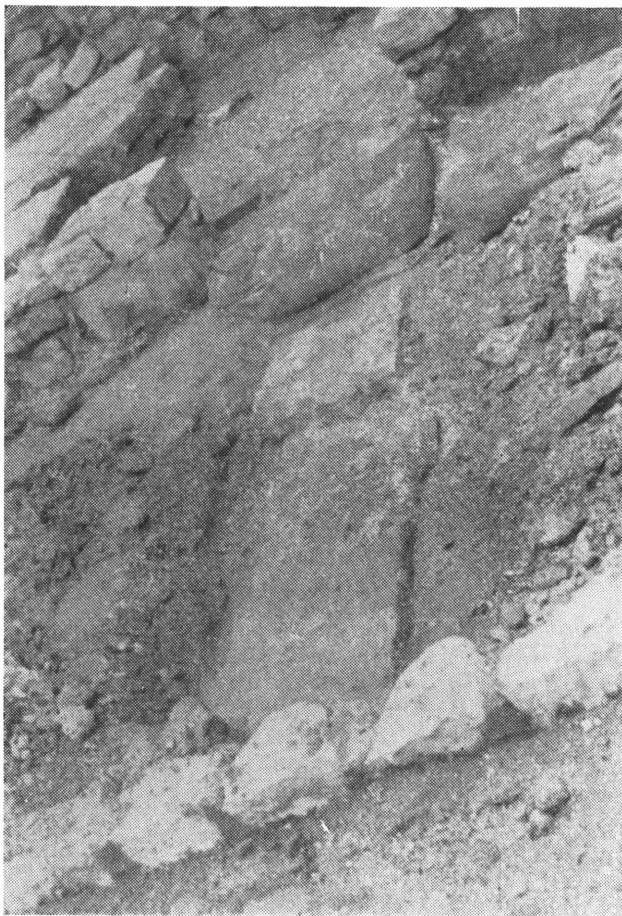
Slika 2. Iskopine na području Eufrazijane
