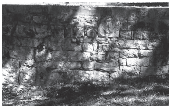
Sl. 4. Zid na Lučcu izrađen od antičkih blokova / Fig. 4. The wall in Lučac, constructed from roman ashlers.
