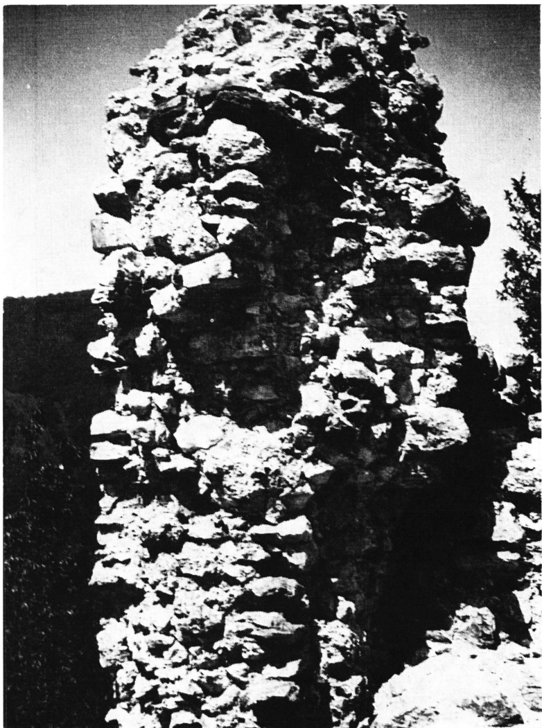
Romaničko zide Lipovca
