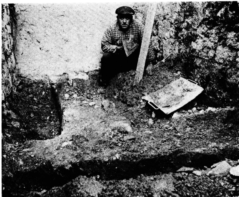
Kosi i okomiti dijelovi zida pred sjevernim dijelom pročelja do zvonika
